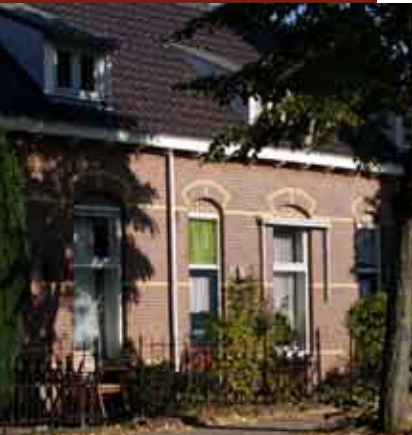
Eerste sociale woningbouw van Nijmegen met karakteristieke gele speklagen en gietijzeren tuinhekjes.
