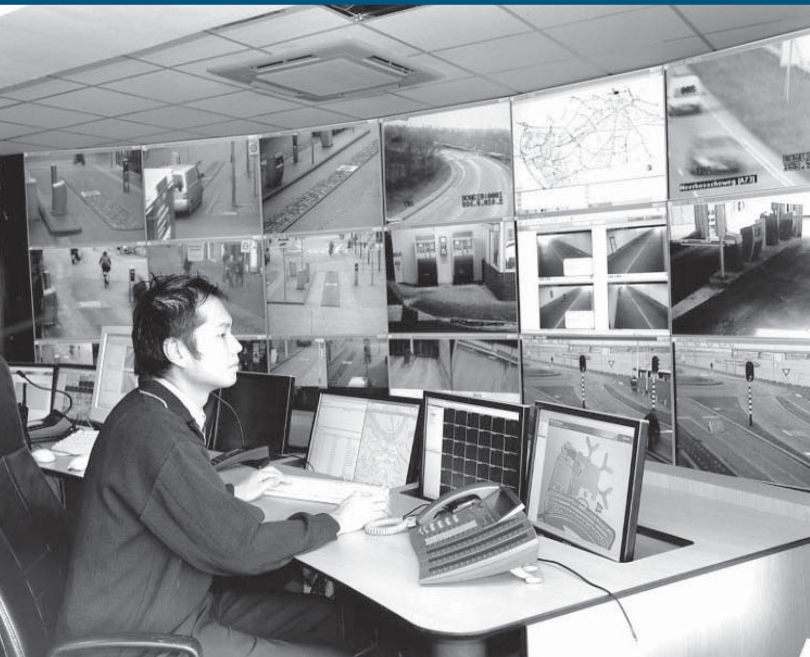
Medewerkers van de verkeersmanagementcentrale houden 24 uur per dag de roadbarrières in de binnenstad en de parkeergarages in de gaten. Alle intercomgesprekken komen in deze kamer binnen.
