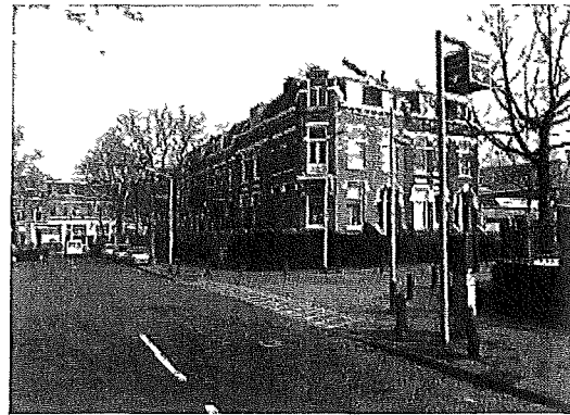
Het blok gezien vanaf de andere kant met de woning op de hoek van de Van Goorstraat. Deze fraaie hoekwoning heeft géén tuin en achter slechts één onbeduidend kamertje dat uitziet op de tuin van zijn buurman
